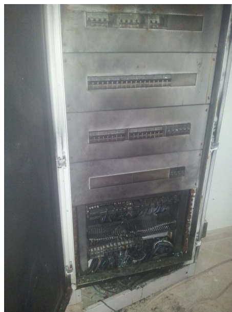
Foto 5 (Quadro elettrico generale danneggiato da incendio)
