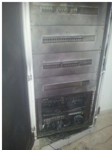
Foto 5 (Quadro elettrico generale danneggiato da incendio)
