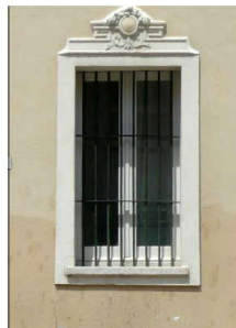
F2_ISOLATO 17 UNITA' a Finestra con schema trilitico con cornice decorata.
