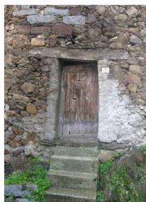
P1_ISOLATO 12 UNITA' m Porta architrave ligneo squadrate poggiante e stipiti in trovanti lapidei ammassati ad una muratura ad opera incerta.
