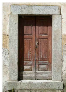
P3_ISOLATO 08 UNITA' a Porta con architrave e stipiti monolitici lapidei squadrate non ammassati alla muratura.
