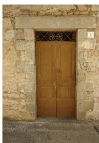
P2_ISOLATO 08 UNITA' f Porta con architrave lapideo e stipiti in pietra squadrate ammassati ad una muratura ad opera incerta.
