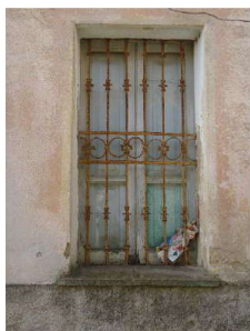
F1_ISOLATO 06 UNITA' p Finestra con schema trilitico intonacato.
